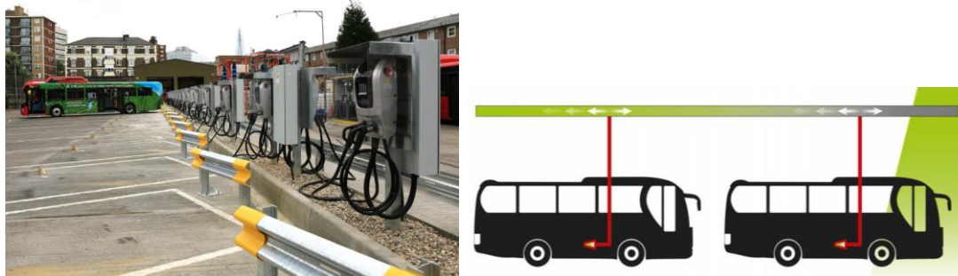
Abbildung 15: Ladepunkte am Betriebshofrand bzw. an der Hallendecke Quelle: Alexander Dennis Limited und Faiveley Stemmann
