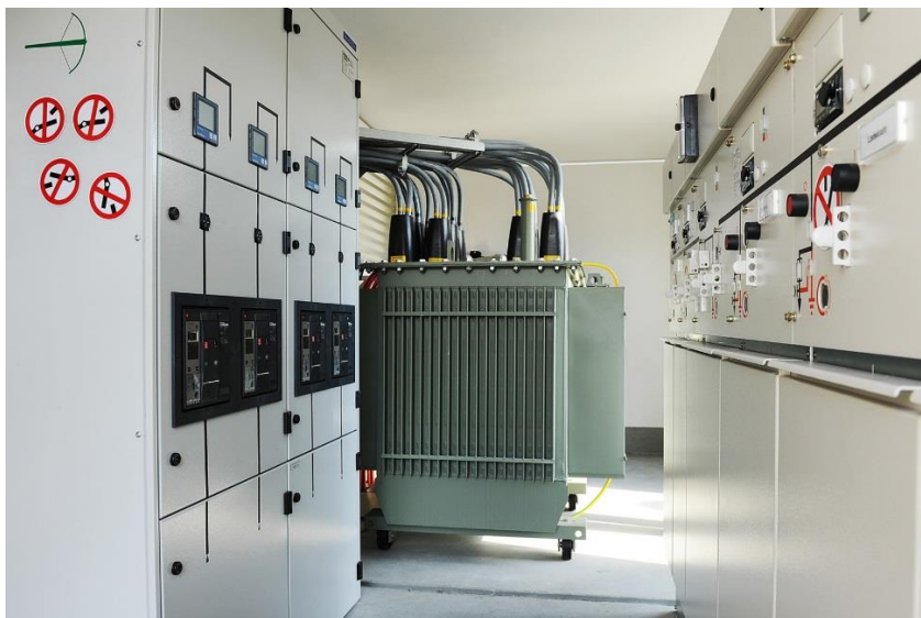
Abbildung 11: Trafostation auf dem Betriebshof in Münster Quelle: Stadtwerke Münster
